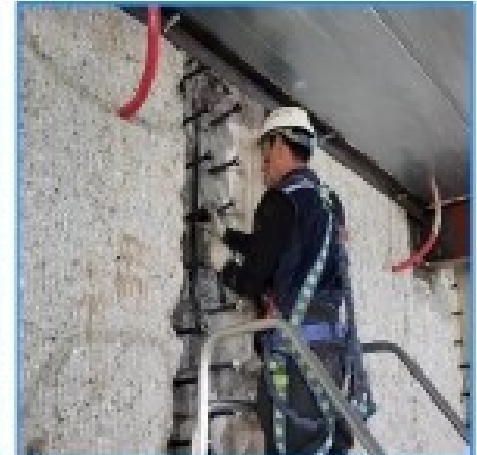
[조인트 지수제 설치]
