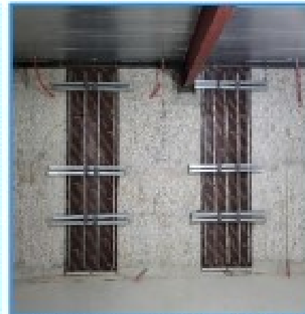
[PILASTER 설치 - 레이콘 타설]
