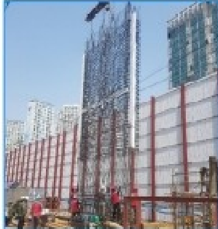
[철근망 연결 및 근입]
