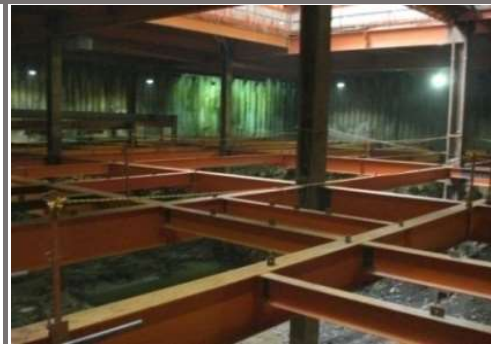
06. 지하 골조 공사
